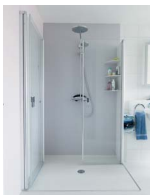
Nachher: Rutschfeste, bodenebene Dusche mit wegfallbarer Duschtrennwand und pflegeleichten Oberflächen
