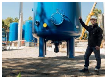
Die Arbeiten für die Naturfilteranlage in Wienerherberg laufen auf Hochtouren. Die tonnenschweren Filter wurden bereits aufgestellt.
