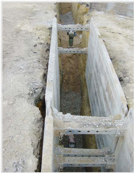
Abbildung 15 | Künette verbaut (Tiefe > 1,25 m)
