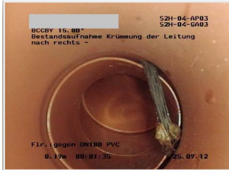
Abbildung 27 | Einragende Dichtung
