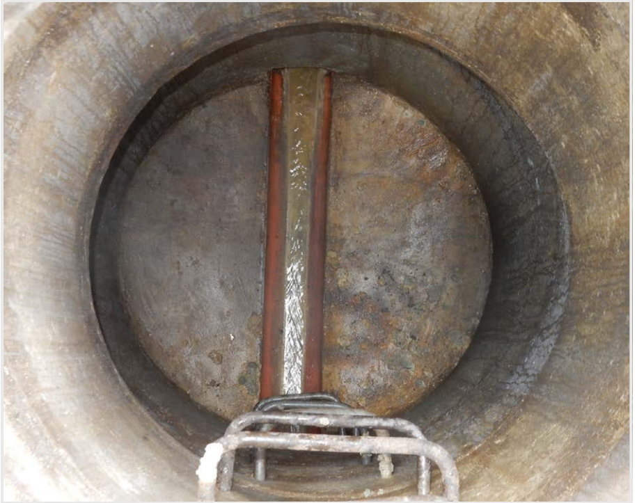
Abbildung 28 | Blick in Kontrollschacht
