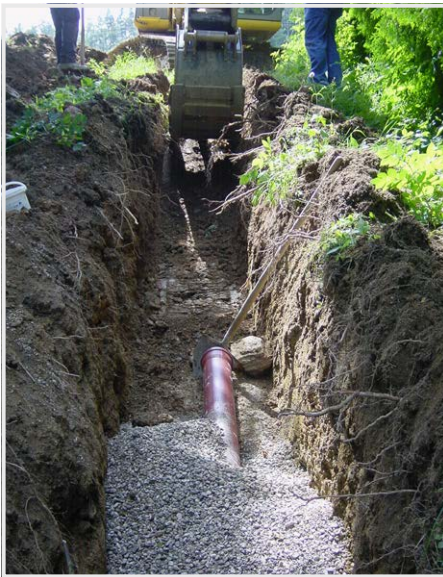
Abbildung 14 | Künette unverbaut (Tiefe < 1,25 m)
