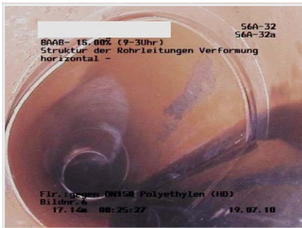
Abbildung 22 | Massive Rohrverformung
