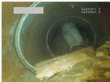
Abbildung 24 | Fehlschluss (Dachrinne)
